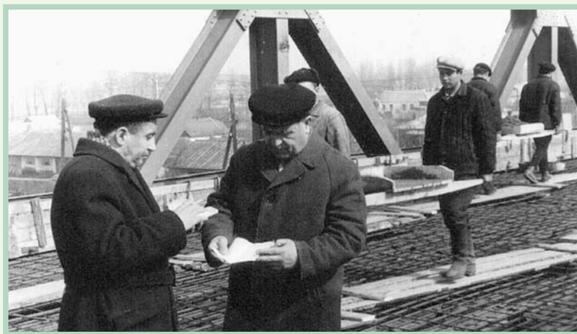
Во время строительства путепровода в Александровке
