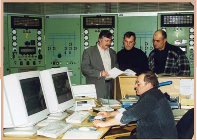
На газокomppressorной станции
