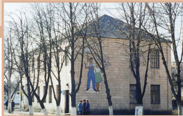
Здание районной библиотеки
