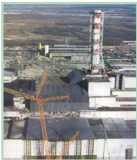
Саркофаг 4-го энергоблока Чернобыльской атомной электростанции
