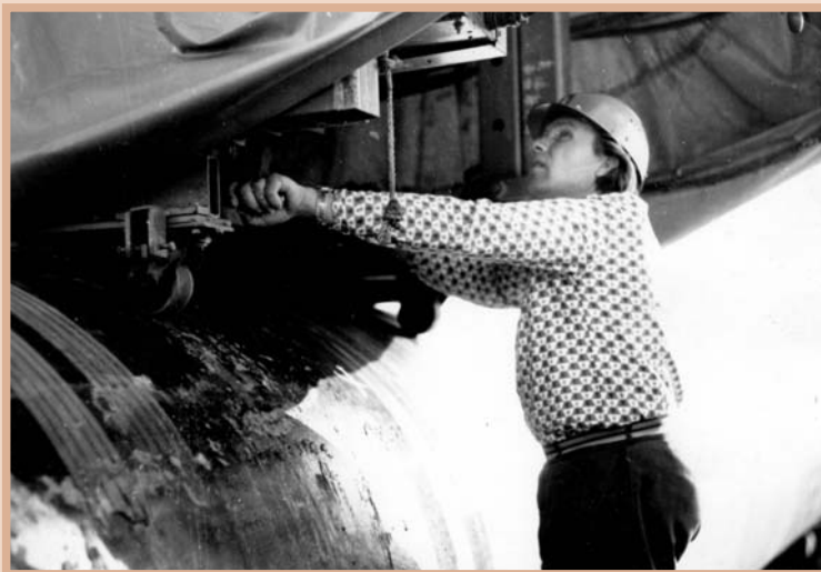
Сварочные работы на строительстве газопровода
