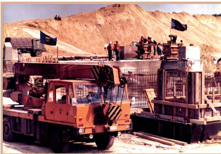
На строительстве газопровода
